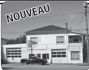
271-273 ST-GEORGES, WINDSOR COMMERCÉ D'USINAGE AVEC LOYER AU 2E.
