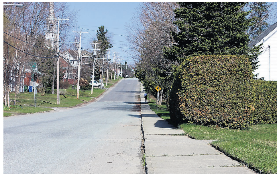
Une portion de trottoirs située sur la rue de l'Église.
