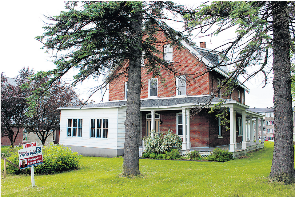
L'ancien presbytère situé entre la nouvelle église et le parc du Centenaire.
