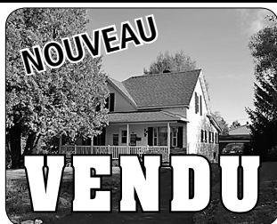
44, 5E AVENUE, WINDSOR COTTAGE 4 CC, GARAGE ET TERRAIN INTIME.
