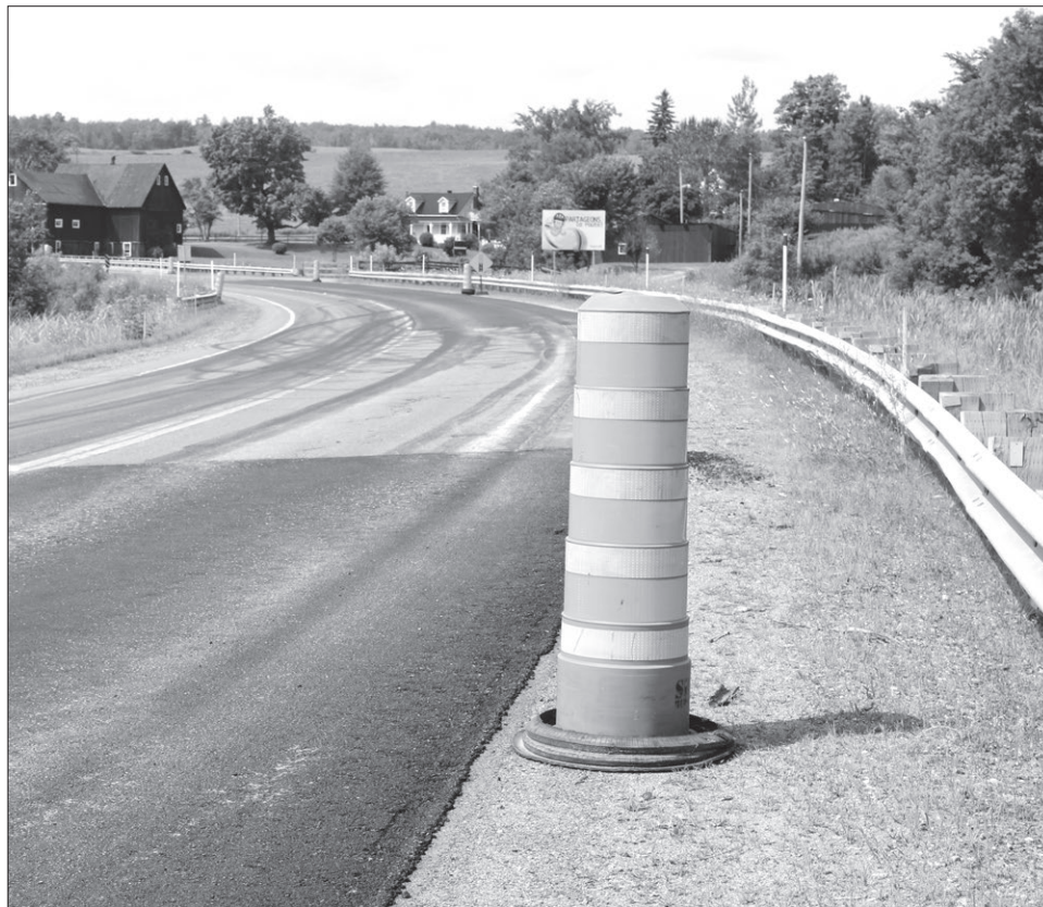
Une portion reconstruite à la hauteur du ruisseau Willow sur la 143.
