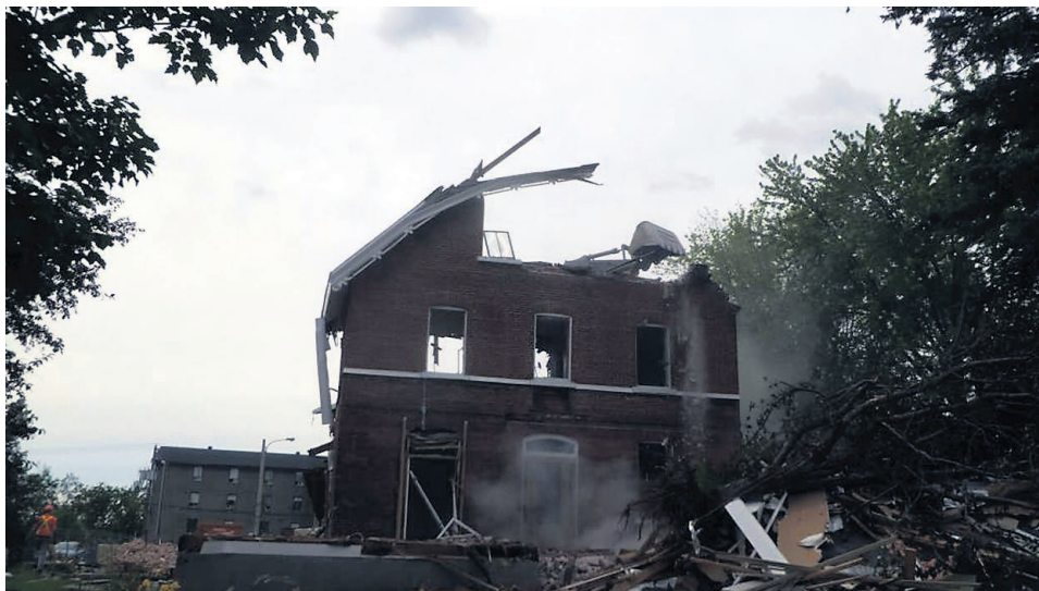
Les travaux de démolition du vieux presbytère de la paroisse Saint-Philippe de Windsor ont débuté samedi dernier.
